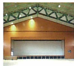
ロインパネル 大東小学校体育館
